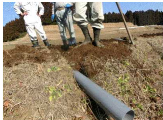
排水対策④パイプの敷設で畦畔の崩壊を防ぎ、ほ場外に水を排出させます。
