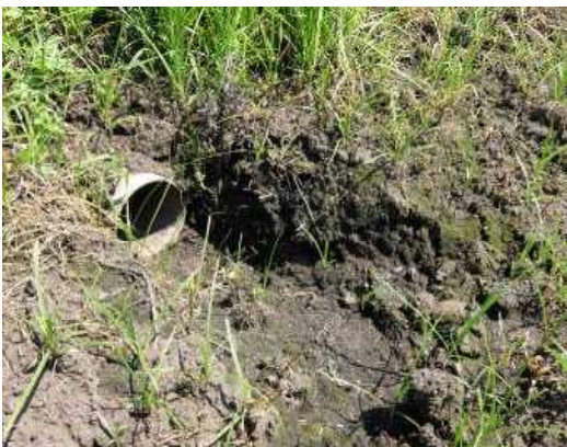
排水対策⑤排水口の点検整備を行います。
